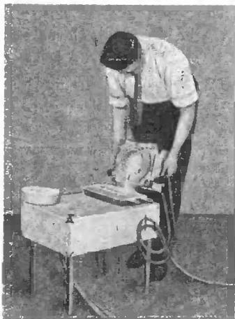
Рис. 2. Выливание расплавленного железа при 1600° из небольшой переносной печи.
